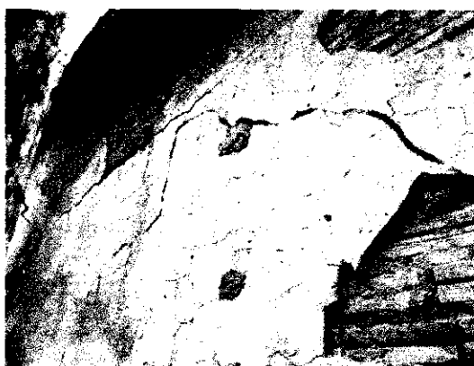
FOTO 6- PAREDES LATERAL COM VARIAS FISSURAS
