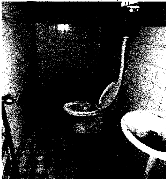
FOTO 13- SITUAÇÃO DE USO DA EDIFICAÇÃO INTERNA
