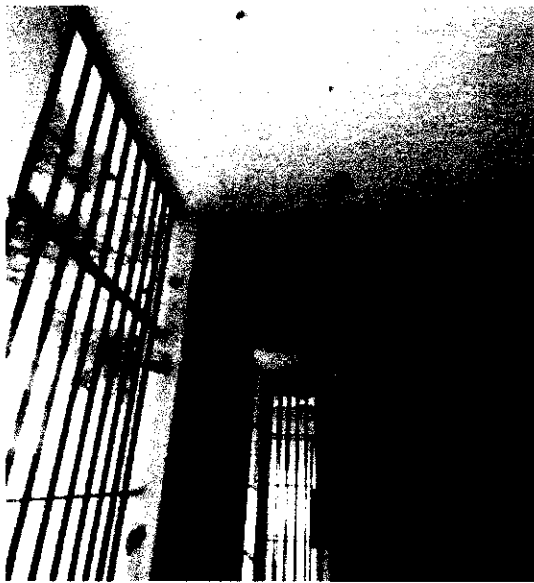
FOTO 12- SITUAÇÃO DE USO DA EDIFICAÇÃO INTERNA
