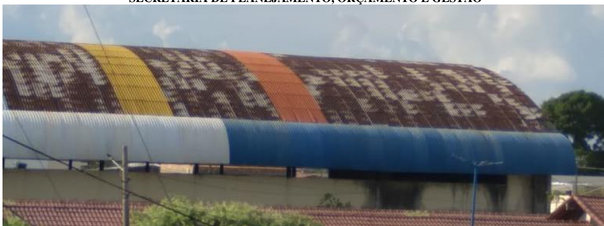
FOTO 1- SITUAÇÃO DE USO DA COBERTURA
