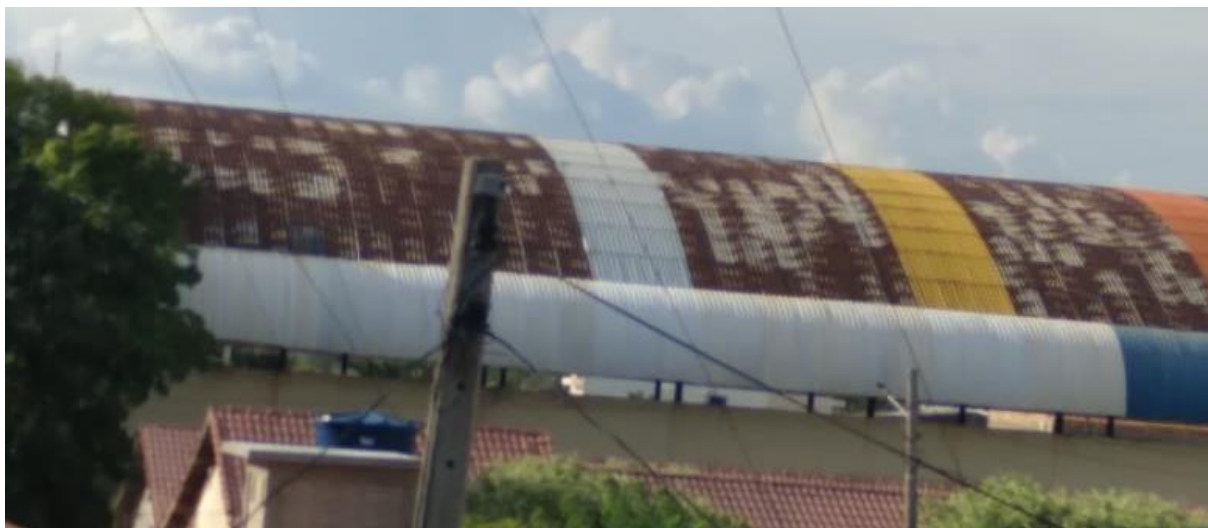
FOTO 2- SITUAÇÃO DE USO DA COBERTURA
