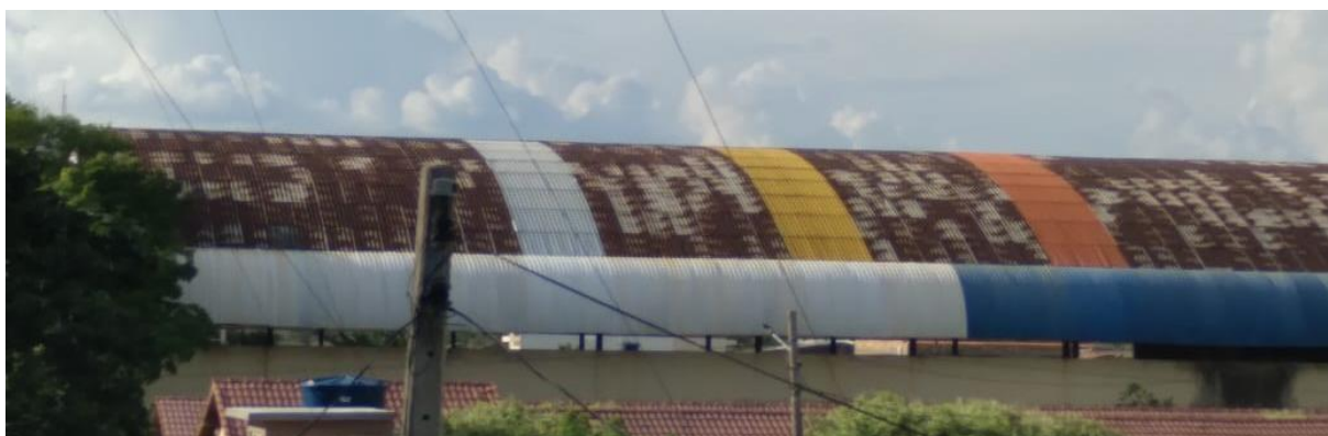
FOTO 3-SITUAÇÃO DE USO DA COBERTURA.
