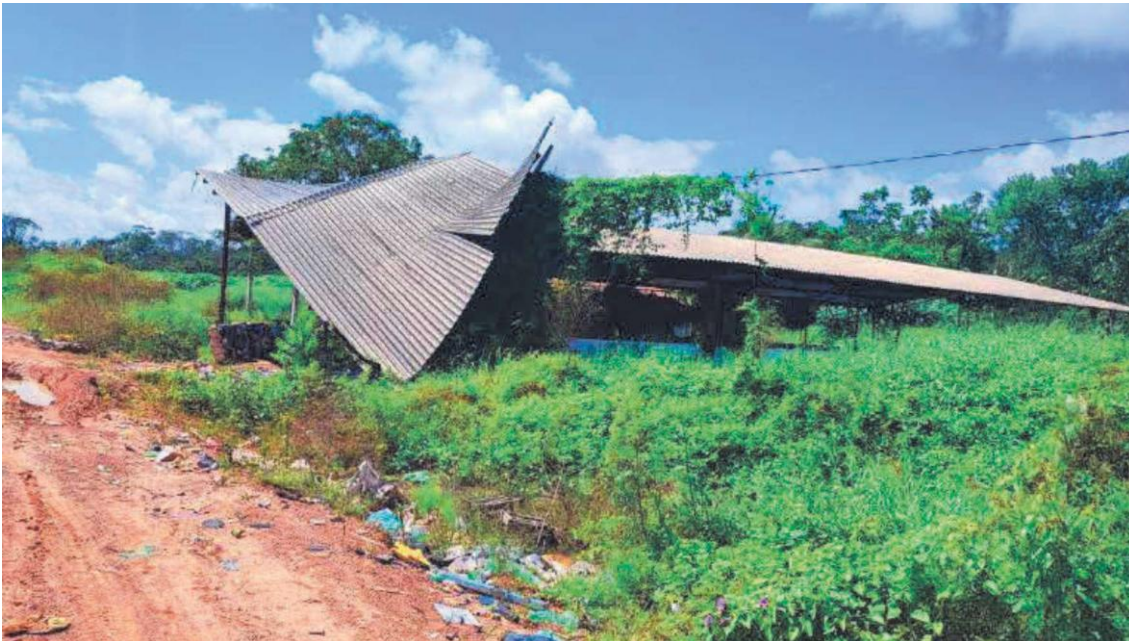
Imagem 13 Antiga estrutura utilizada para gestão de resíduos sólidos
