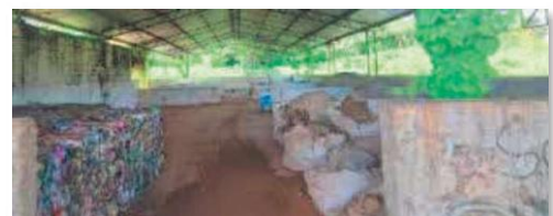
O local, mesmo em condições precárias, ainda é utilizado como local de armazenamento.
