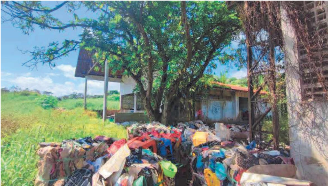
Imagem 17 –Antiga estrutura utilizada para gestão de resíduos sólidos
