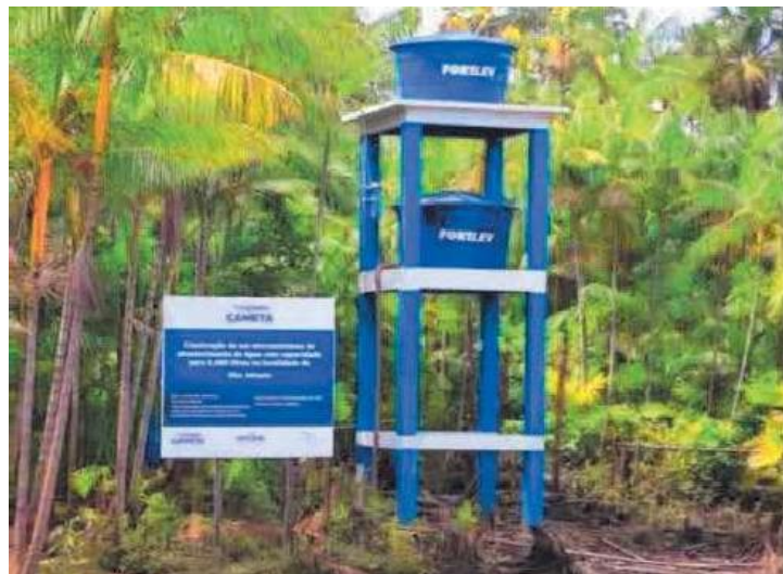
Figura 3- Imagem do sistema de reservatório e tratamento de água utilizado na região das ilhas de Cametá, Pará.
