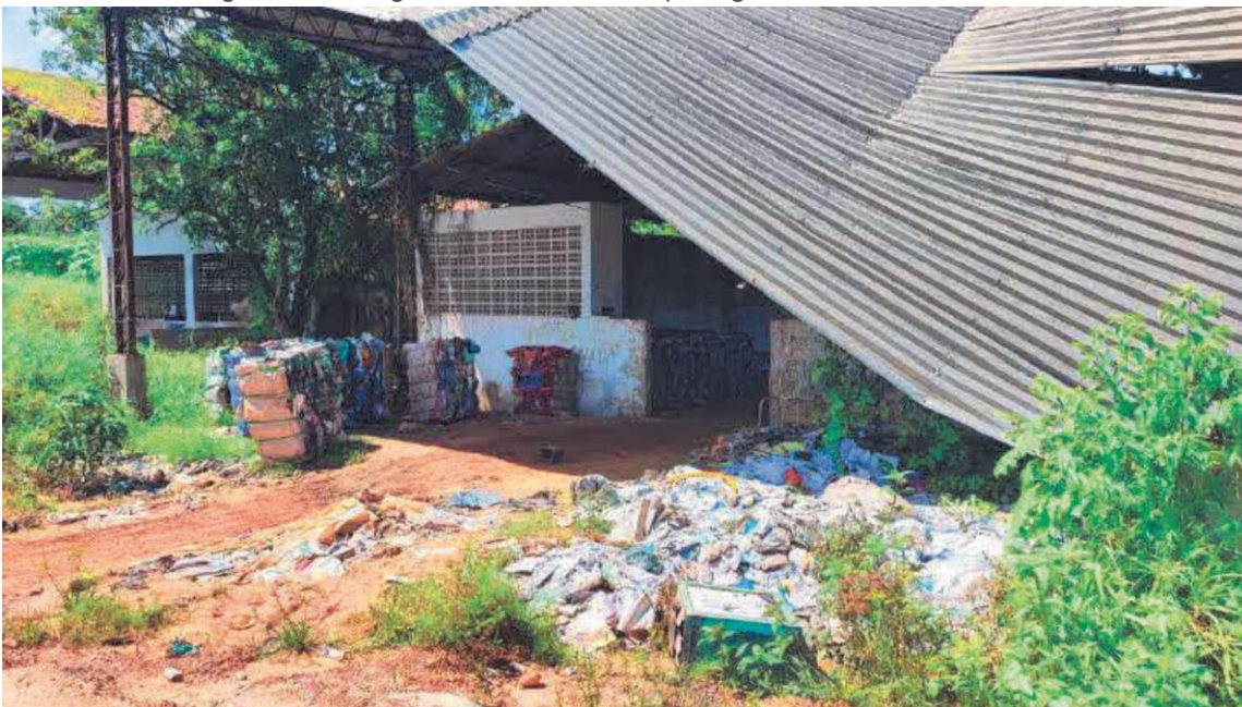
Imagem 14 –Antiga estrutura utilizada para gestão de resíduos sólidos
