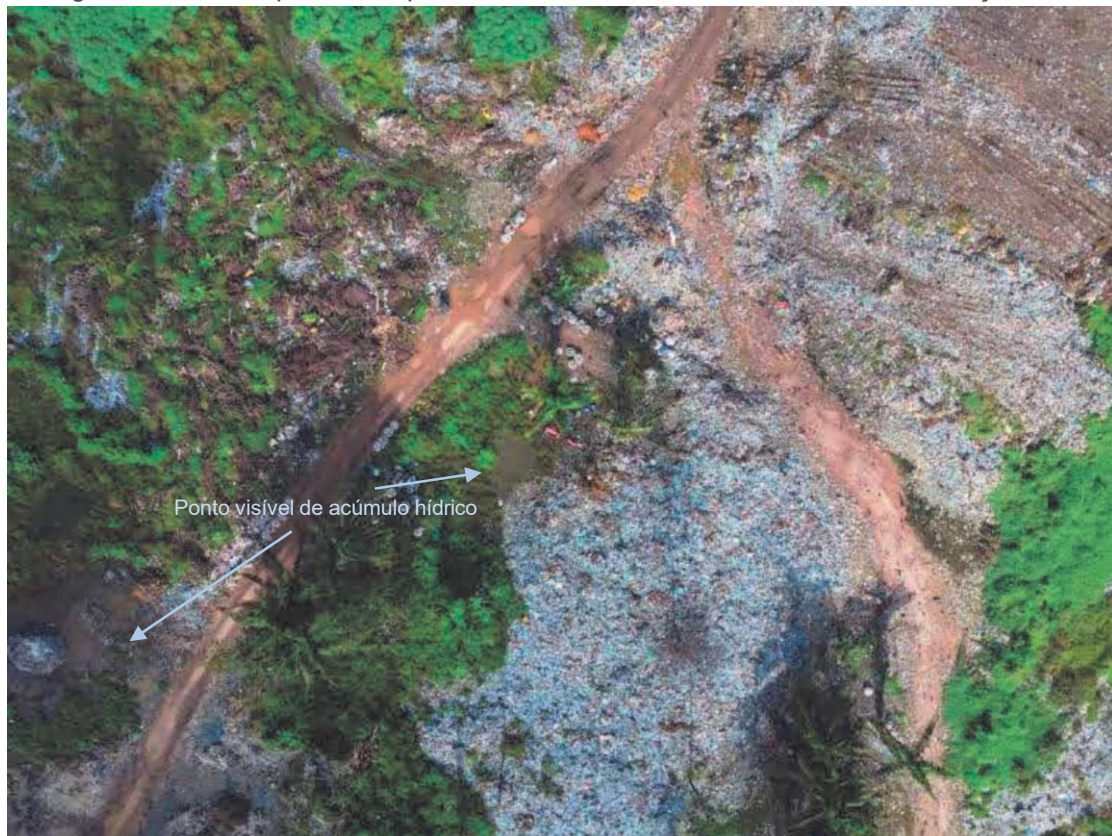
Imagem 03 - Vista superior com pontos de resíduos, acúmulo de chorume e situação viária.
