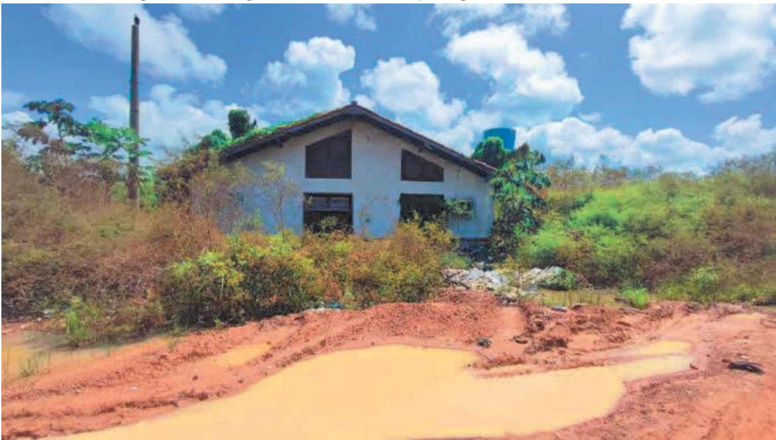
Imagem 18 –Antiga estrutura utilizada para gestão de resíduos sólidos
