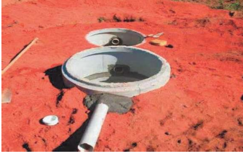
Figura 4- Imagem do sistema de fossas sépticas usadas em Cametá, PA. No município não existe sistema coletivo de saneamento básico.
